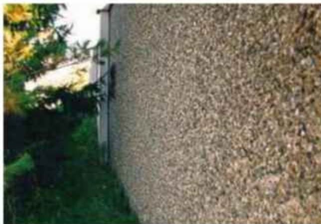
Слика 3.81. Бетонска баријера са површином у виду каменог агрегата [25]
