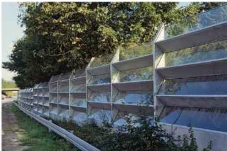
Слика 3.26. Пример комбинације апсорпционог и транспарентног зида [24]
