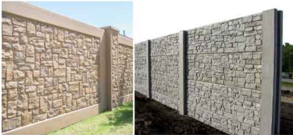
Слика 3.82. Текстура бетонске баријере добијена у калупу: а) [76], б) [67]
