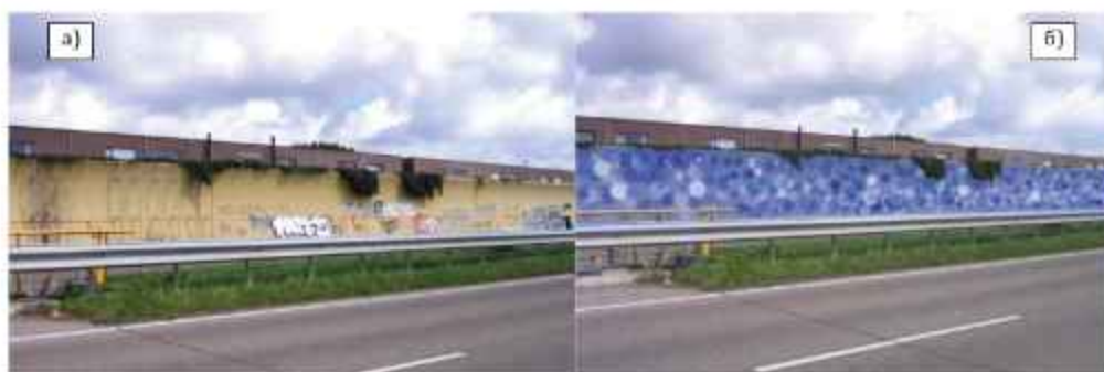
Слика 3.93. Примери графита и анти-графита на звучним баријерама [24]
