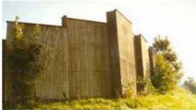
Слика 3.90. Ламинација – дрвене баријере [25]
