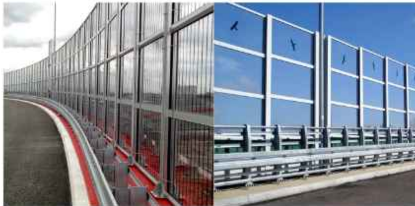
Слика 3.91. Површинска текстура – провидне баријере [80]
