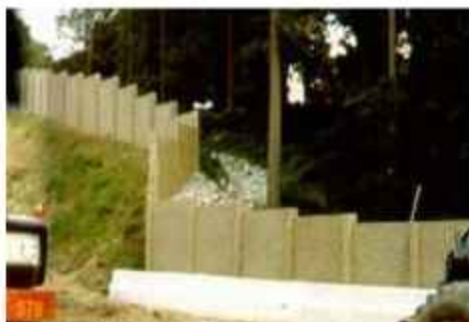
Слика 4.17 Варијације промене правца баријере у зависности од конфигурације терена баријере [87]
