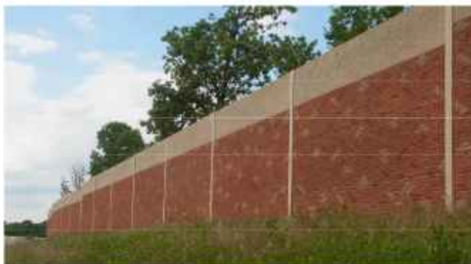
Слика 3.69. Пример звучне баријере од цигле [67]
