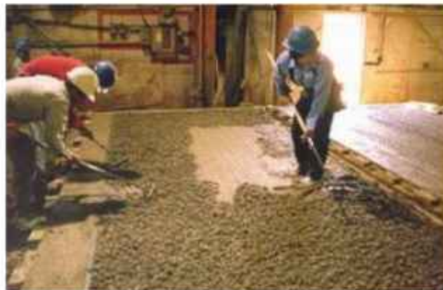
Слика 3.83. Завршна обрада бетонске баријере грабуљањем [25]
