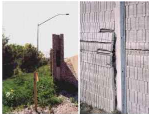
Слика 3.17. Примери зида за парцијално задржавање земље [25]
