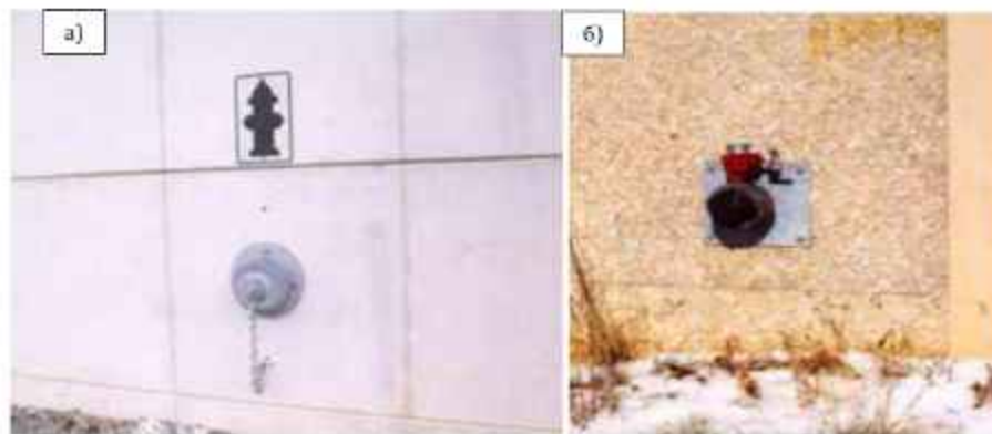
Слика 5.14. Пожарна сигурност: а) спојница за ватрогасно црево интегрисана у панеле, б) вентил интегрисан у панеле [25]
