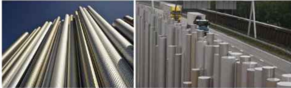
Слика 3.39. Пример специјалних цевних апсорбера [53]
