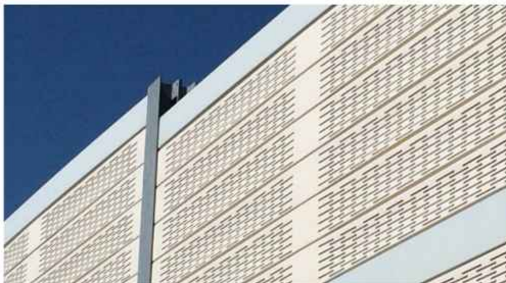
Слика 3.75. Примери апсорпционих пластичних баријера [72]
