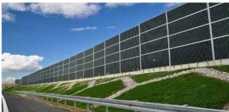
Слика 3.24. Примери комбинације звучних зидова и земљаних насипа [48]
