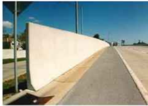
Слика 3.18. Пример зида од бетона изливеног на месту пројекта [25]
