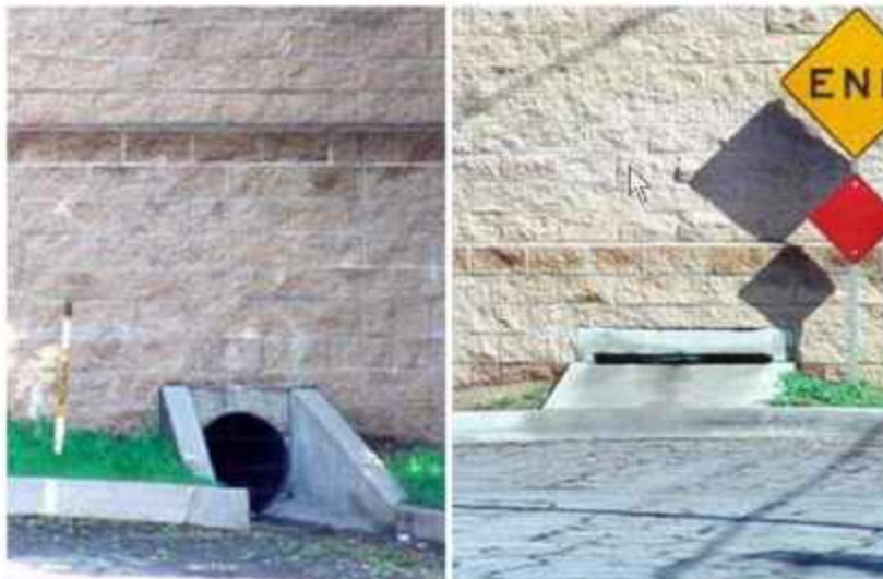
Слика 3.58. Дренажни отвори за одвођење воде испод баријере [25]
