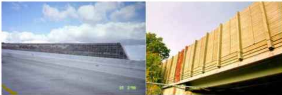
Слика 3.19. Примери звучних зидова на мостовима [25]
