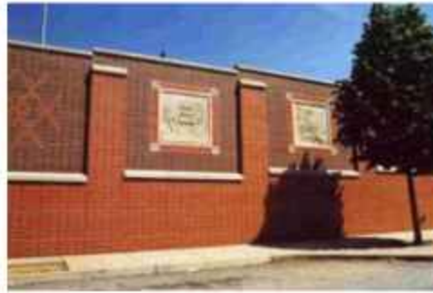
Слика 3.85. Панелни умети причвршћени на бетонску баријеру [25]
