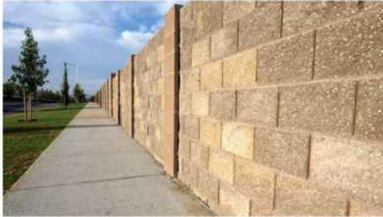
Слика 3.70. Пример звучне баријере од зиданих блокова [68]
