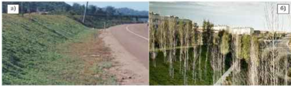
Слика 3.8. Пример земљаног насипа, без засада [38] и са засадом [47]
