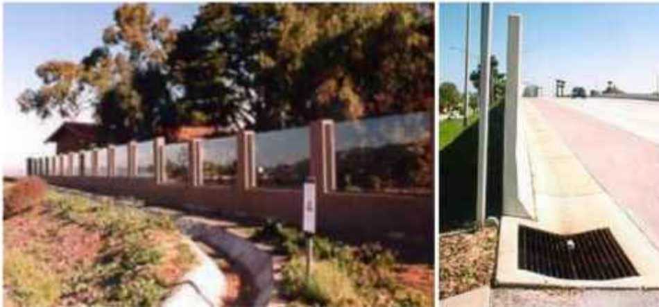
Слика 3.57 Одвођење воде поред баријере [25]
