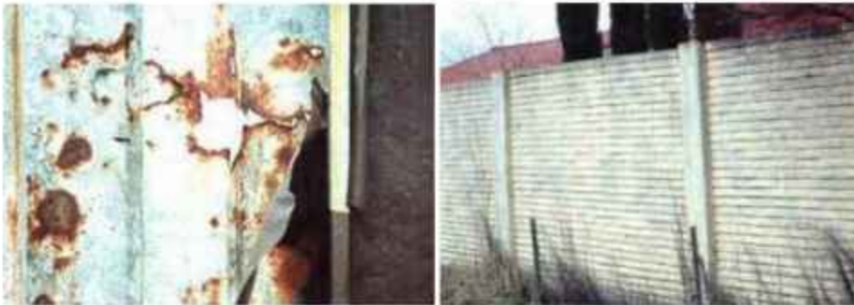
Слика 5.6. Оштећења од влаге и УВ зрачења [25]
