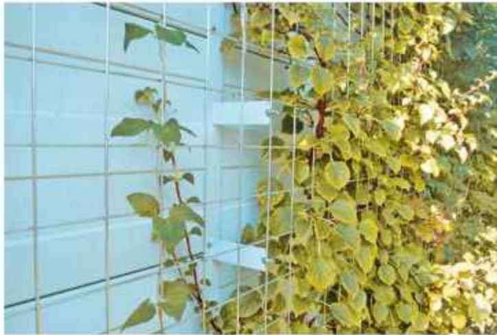
Слика 3.64. Вертикални ослонци за биљке пењачице [63]
