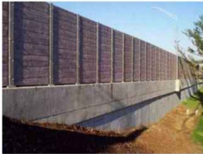
Слика 3.20. Пример звучног зида на потпорном зиду [25]
