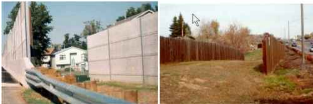
Слика 3.54. Отвори за хитне случајеве: преклапање баријера [25]
