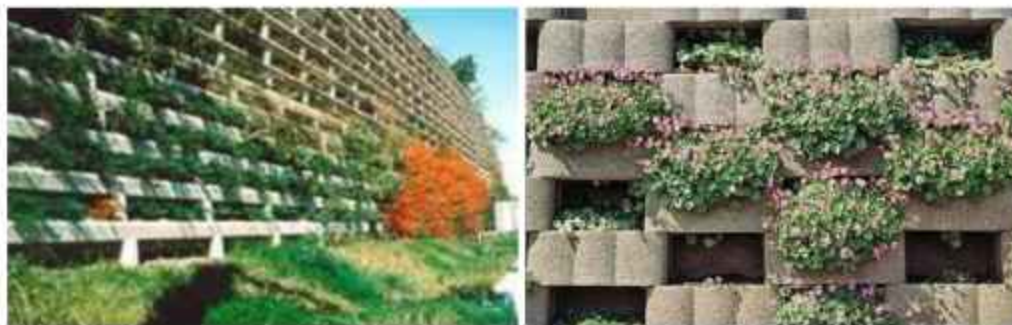
Слика 3.13. Самостојећи бетонски зидови са биљним засадима [25]
