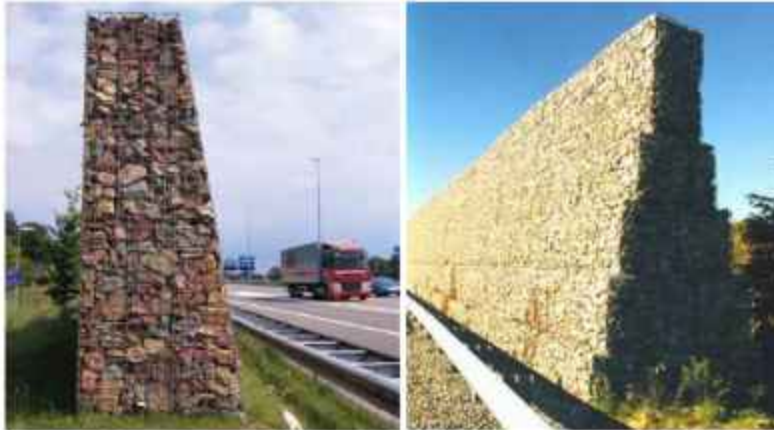
Слика 3.14. Примери габионских баријера [25], [43]
