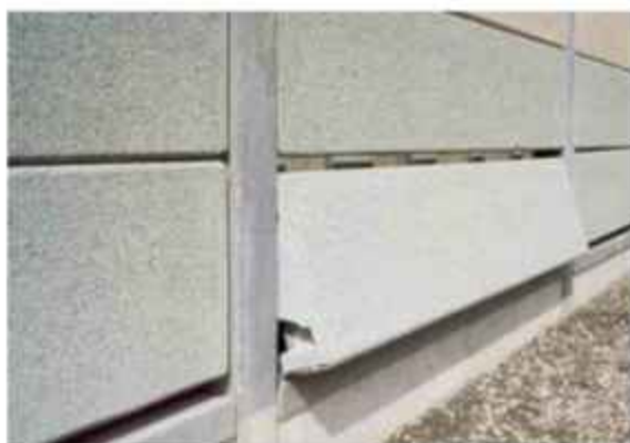
Слика 3.59. Покретни сегменти баријере за одвођење воде [25]
