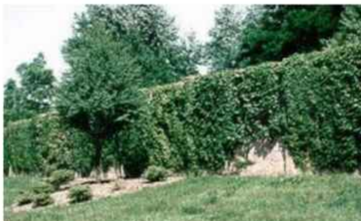
Слика 3.25. Пример комбинације звучног зида са вегетацијом [24]
