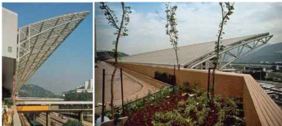
Слика 3.33. Примери конзолних баријера интегрисаних у постојеће објекте [24]
