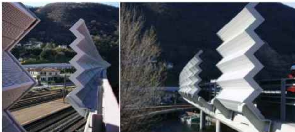
Слика 3.36. Пример степенастог „цик-цак“ зида [24]
