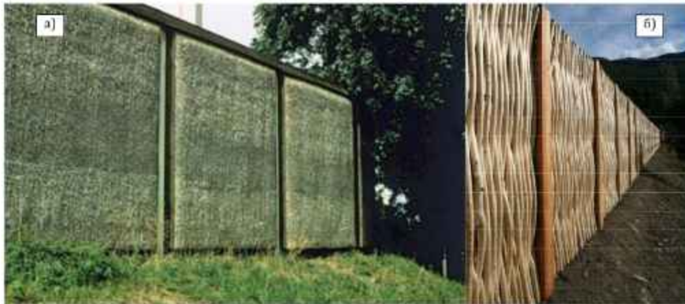
Слика 3.73. Пример баријере од: а) трске [24] и б) плетеног прућа [70]
