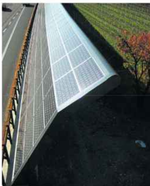
Слика 3.27. Пример баријере са соларним панелима [49]
