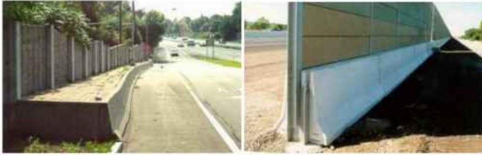
Слика 3.63. Бетонске преграде за заштиту баријере од саобраћаја [25]
